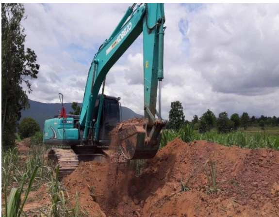
ขณะดำเนินการวางระบบท่อส่งน้ำ
